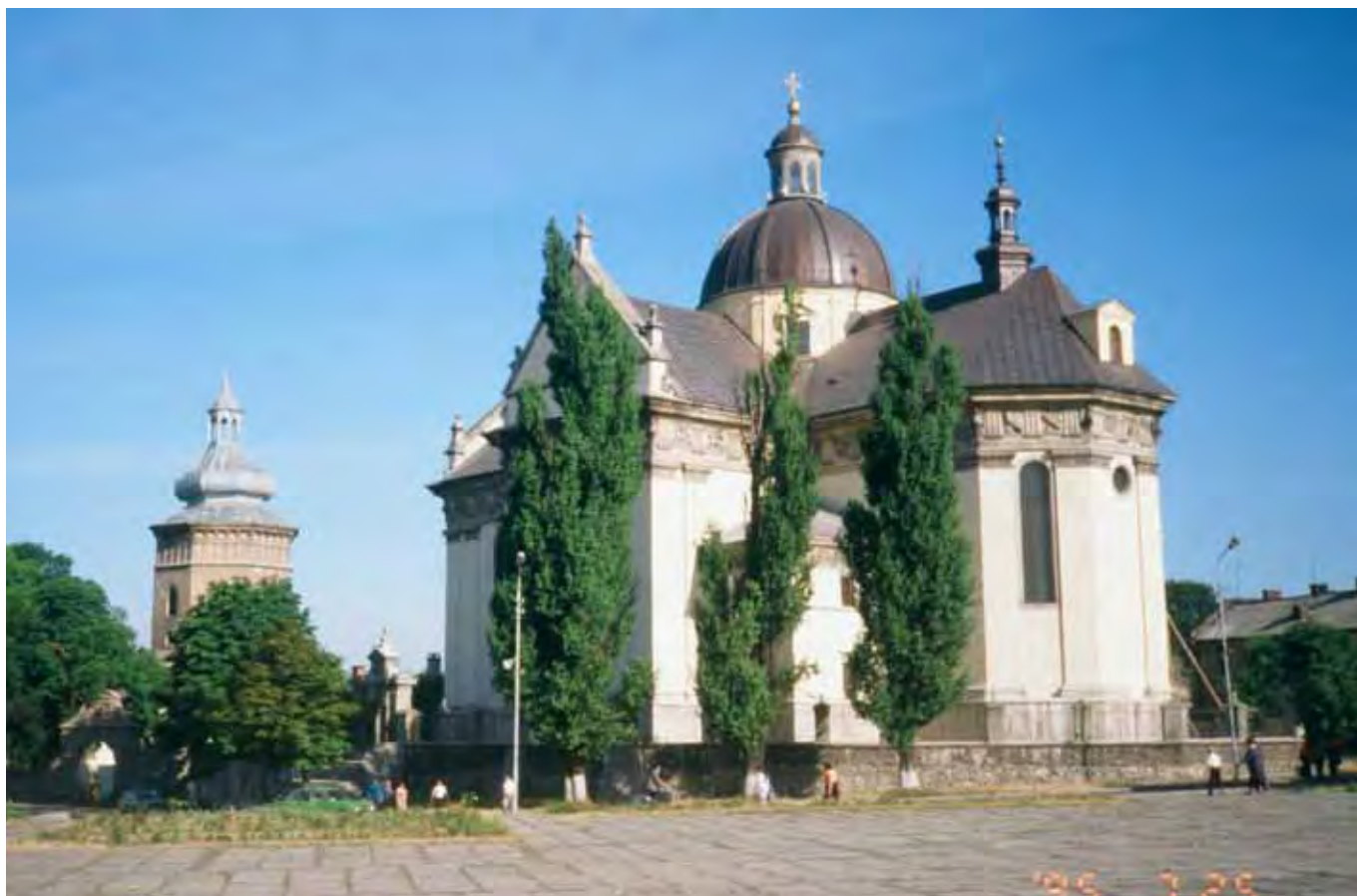
Elewacja południowo-wschodnia zespołu sakralnego pw. św. Wawrzyńca w Żółkwi (P.K.)
